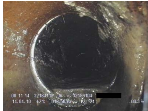
Bild 2: Innenaufnahme eines Abwasserkanals (Quelle: Berliner Wasserbetriebe)
