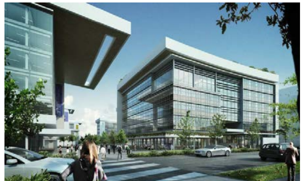
Bild 1: Gebäude des Forschungscampus DPP – Bezug im Sommer 2015 (Quelle: RWTH Aachen)
