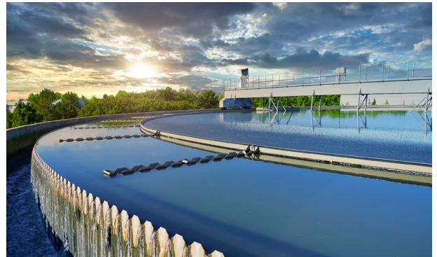
Kläranlage als Einsatzort für die Inline-Prozessüberwachung.
