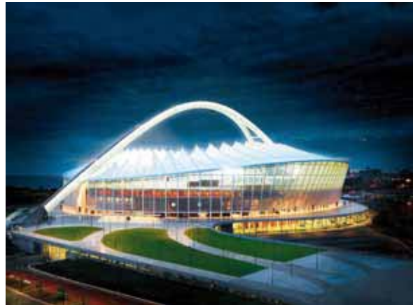
WM-Stadion in Durban mit LED-Lichtbogen, Quelle: OSRAM GmbH
